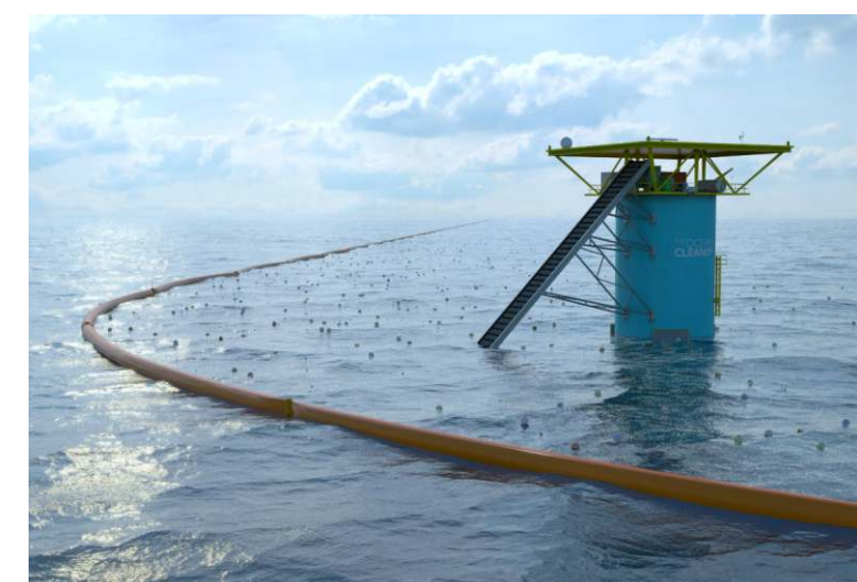
5. Плавающие понтоны, которые автоматически собирают встречающийся мусор во внутренние баки
