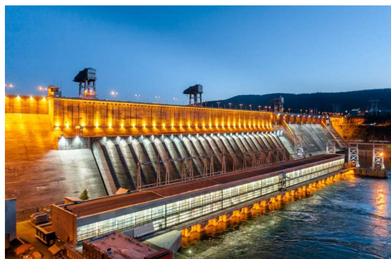
1. Очистные станции на ГЭС
